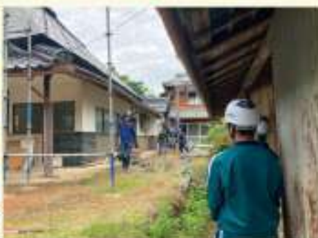
足場組立て・古民家リノ ベーション現場見学
