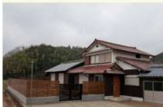
築 40 年の中古住宅のリノベーション工事
