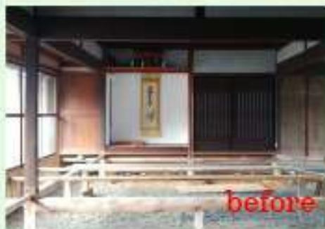
既存の柱や梁、建具を残し、窓や壁は撤去し新しいものに替えます。
