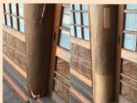
柱の修復工事 篠山市金照寺様
