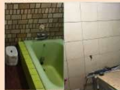
浴室工事。解体後、大工仕事へ。 タイルを貼り替えました。篠山市U様邸
