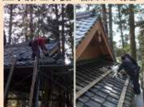
台風で壊れた瓦屋根の修復工事を 行いました。三田市駒宇佐八幡宮様
