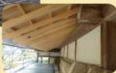
福住伝建地区 住吉神社改修工事中 完成までもうすぐです
