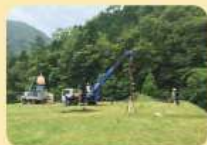
I様邸 新築工事中(篠山市) 地盤改良が終わりました
