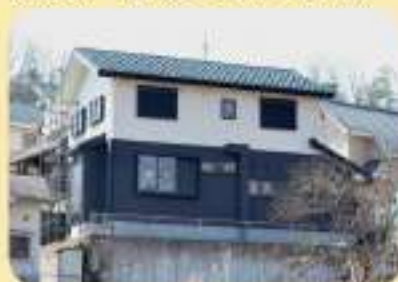
S様邸 新築工事(三田市)
